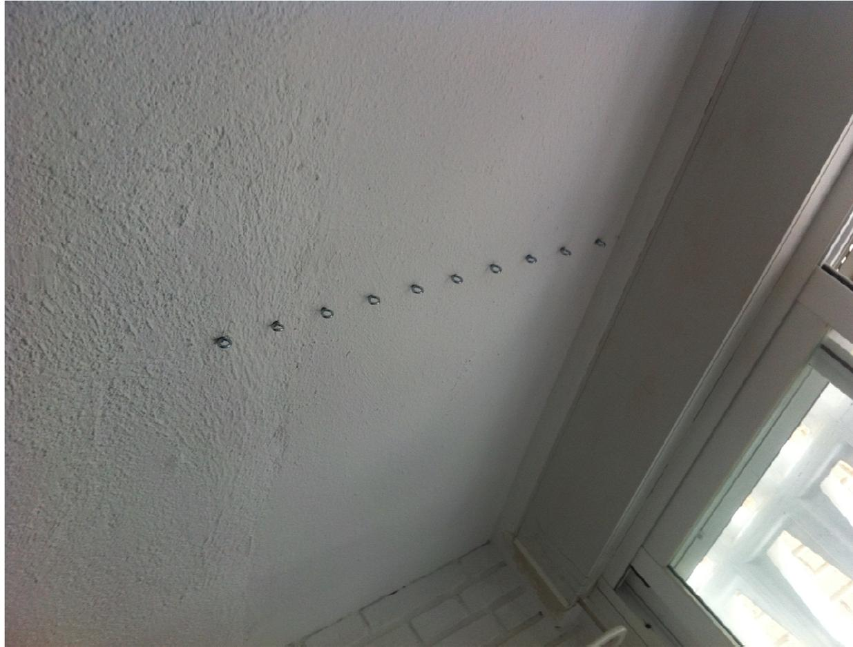
**LISTÓN DE MADERA FIJADO EN PARED. CON CÁNCAMOS DE GUIADO VERTICAL.
